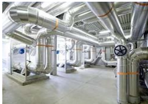
GRUPPI FRIGO AD ASSORBIMENTO ED A COMPRESSIONE ABSORPTION AND COMPRESSION CHILLERS REFROIDISSEURS À ABSORPTION ET À COMPRESSION
