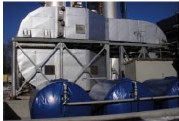
SISTEMA DeNOx SYSTEM DeNOx SYSTÈME DeNOx
