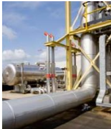
CHAUDIÈRE À VAPEUR ET DÉGAZEUR
