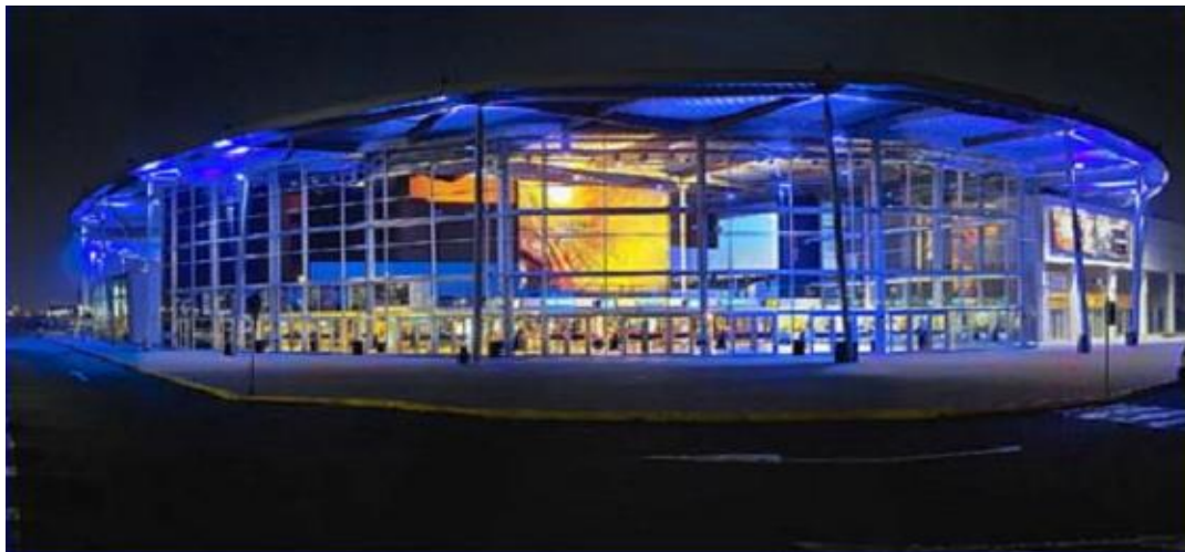
VISTA DI INSIEME DEL COMPLESSO VIEW OF THE COMPLEX VUE d'ENSEMBLE
