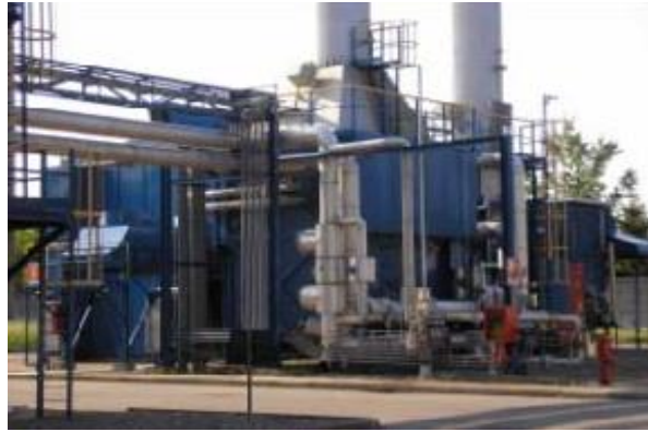
CALDAIA A RECUPERO RECOVERY BOILER CHAUDIÈRE DE RÉCUPÉRATION
